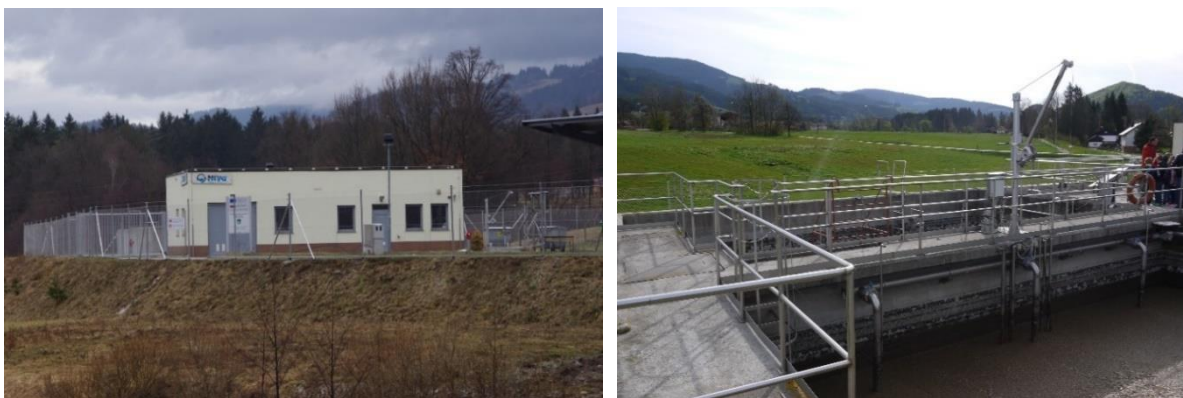
Slika 9: Čistilna naprava Mislinja.
