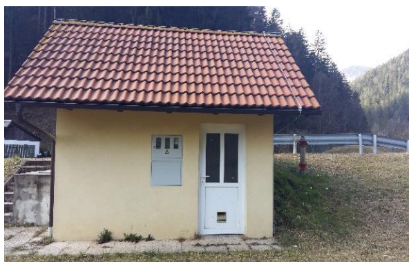
Slika 6: Mala hidroelektrarna v Suhem dolu.
