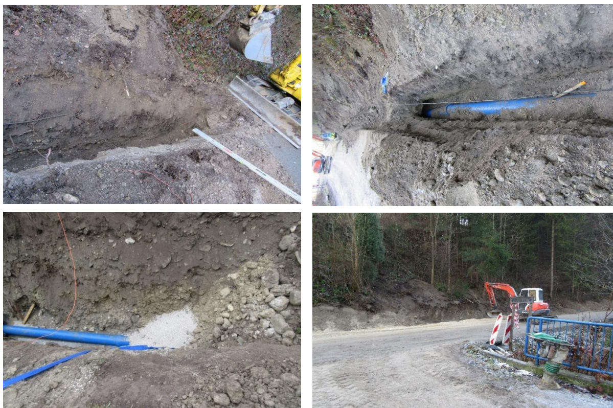
Slika 5: V Suhem dolu smo zamenjali 871 metrov vodovodnih cevi.
